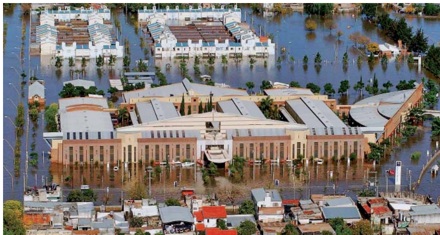
El nuevo Hospital de Niños anegado por las aguas del Salado en la catástrofe de 2003.
