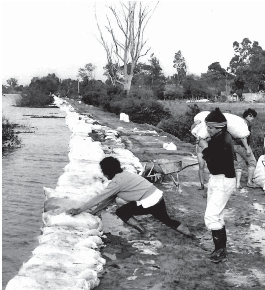
Refuerzo de un terraplén con bolsas de arena en la zona de Rincón durante la crecida de 1992. Foto: Archivo El Litoral
